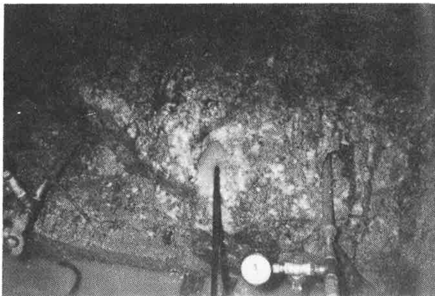
Figur 2.7 Spolning av bottenhål, bredvid en Flex Mix-manschett
