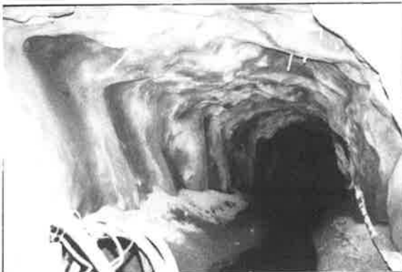
C. Sprutbetong
