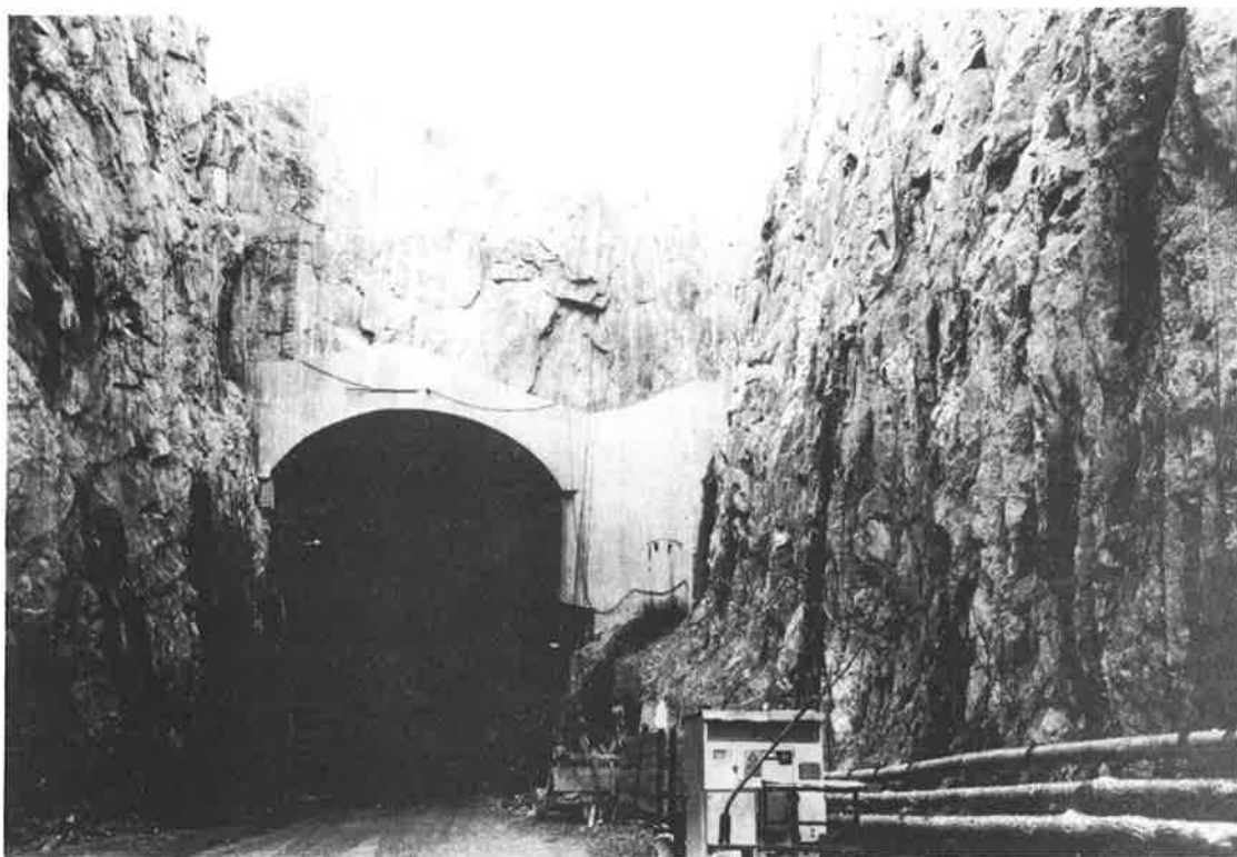
Figur 13 Betongförstärkning av tunnelpåslaget. Foto: Lars Hansen.
