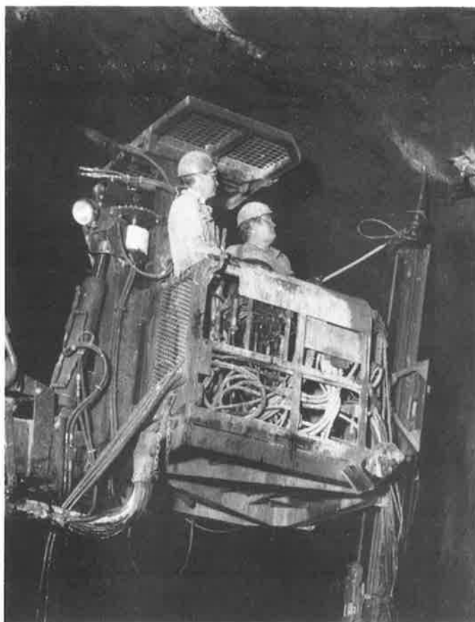
Figur 7 Säkringsarbete med Swellex-bultar. Safety work with Swellex bolts.
