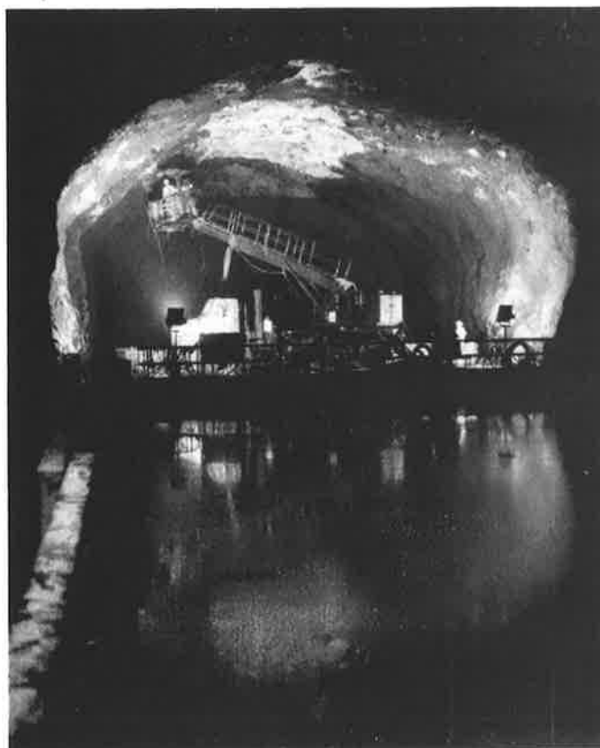
Figur 5 Förstärknings- och saneringsarbetena gjordes från en flytande ponton. The work was performed from a floating platform.
