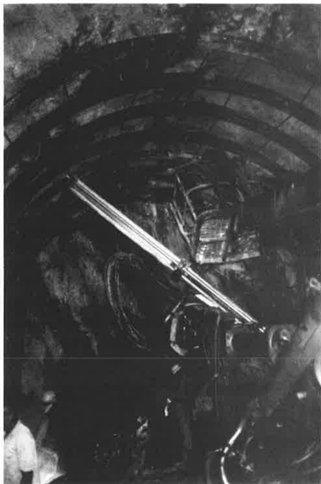
Fig 3. Installation av stålågar och bult (installation of steel-ribs and bolts)
