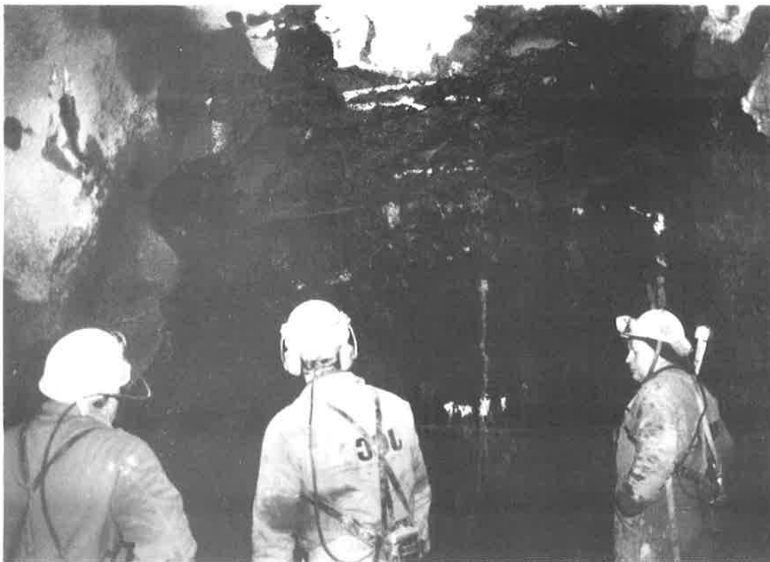
Fig 4. Tunnelfront med jetpelarförstärkt jord i taket.
