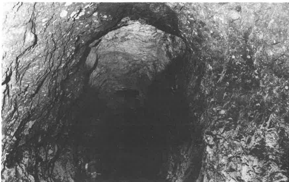
Figure 12 Elevated part of the roof in the Håverud headrace tunnel. Förhöjt tak i Håverud tilloppstunnel.
