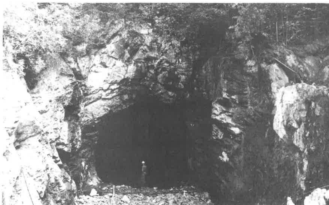
Figure 17 Upstream opening of the Håverud headrace tunnel. The joints to the left are not frequent inside the tunnel. The steeply dipping fracture above the spring line has a smooth surface and is probably related to the fault that constitutes the river gorge. The photograph also shows the gently westwards dipping joints which are common in the tunnel. Håverud tilloppstunnels uppströms öppning. Sprickorna till vänster är inte särskilt vanliga inuti tunneln. Den branta sprickan ovanför anfanget har en slät yta och har troligen samband med förkastningen som utgör Upperudsälvens klyfta. Bilden visar också de flackt västligt stupande sprickgruppen som är vanliga i tunneln.
