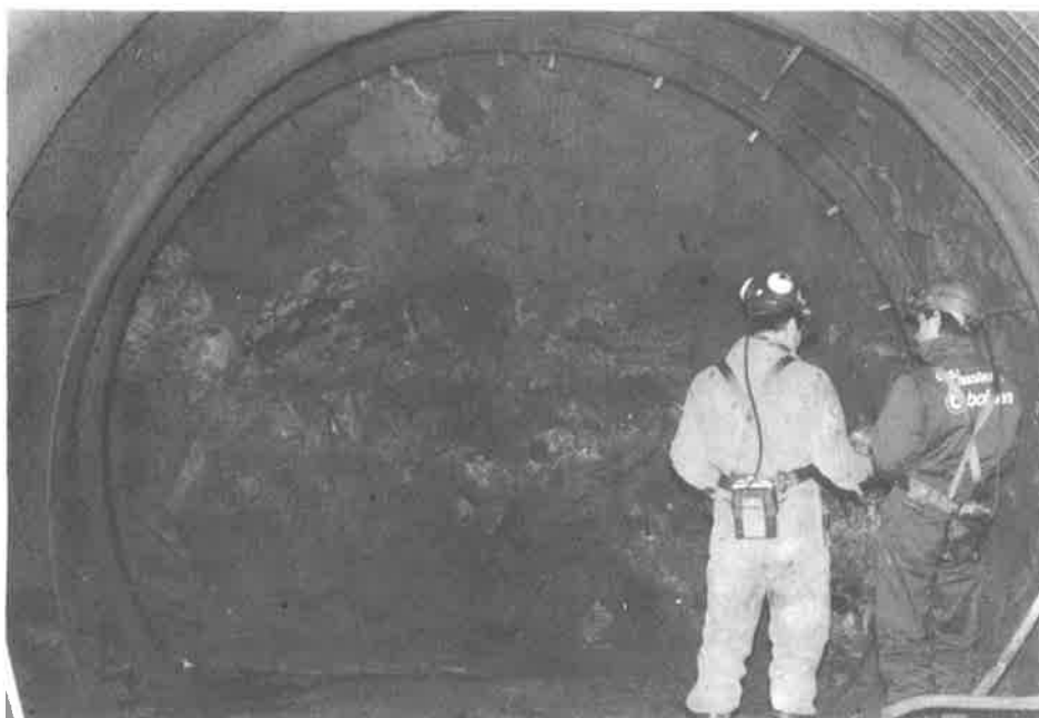
Figur 3 Direkt efter urlastningen betongsprutades väggar, tak och även delen av fronten. Immediately after the excavation, shotcrete was applied on the roof, the walls and on the upper part of the face.
