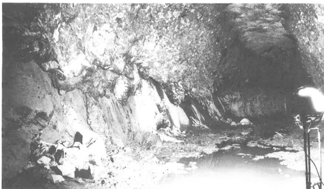
Figure 16 Steeply northward dipping joint on the right wall of the Håverud headrace tunnel. Brant, nordligt stupande spricka på södra väggen av Håverud tilloppstunnel.
