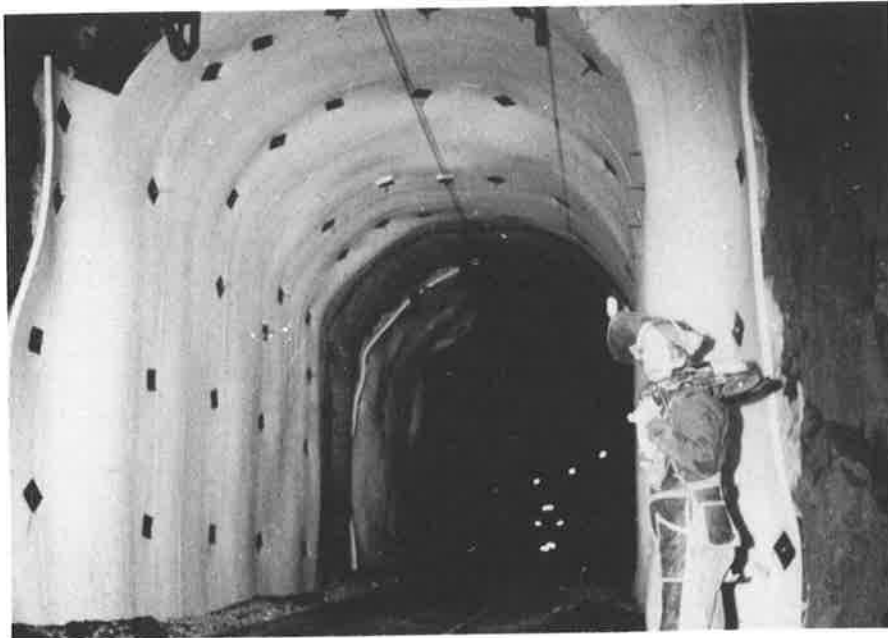
Fig 12. Isolering av tunnel Insulation of a tunnel
