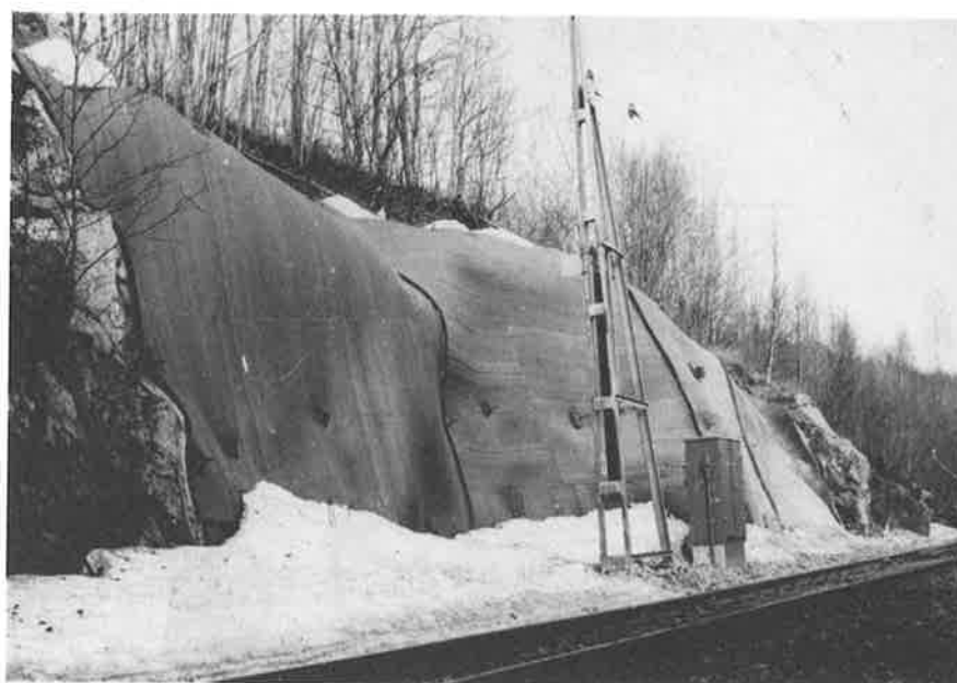
Fig 10. Isolering av bergskärning
