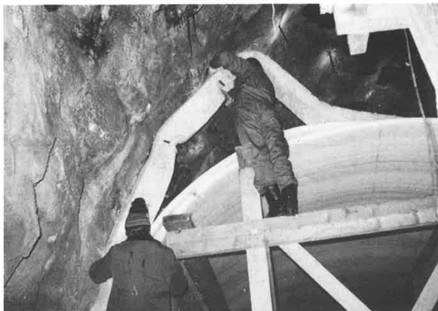
Fig 13. Tätning vid mattkanten med Gullfibers bjälklagslängd
