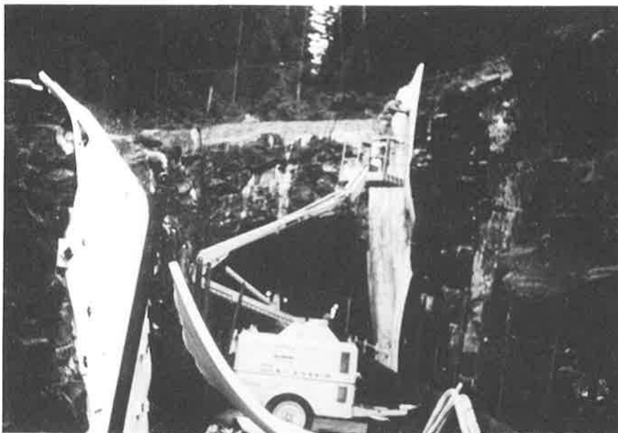
Fig 9. Montering av isolering med sky-lift
