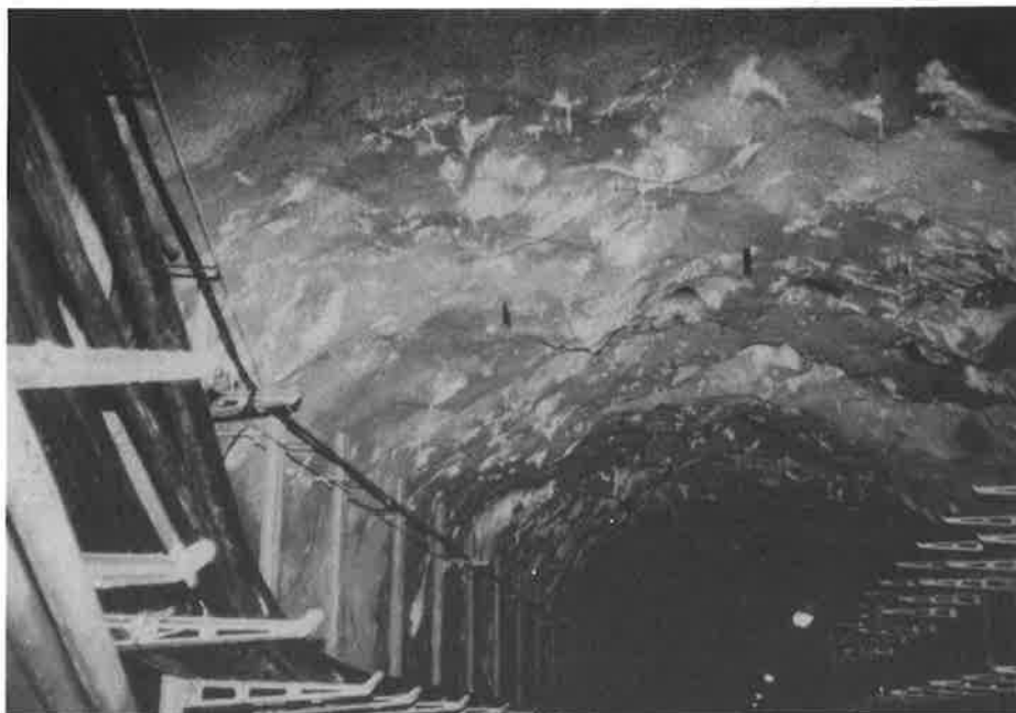
FIGUR 5 Tunnel med isbildning Tunnel with iceformations
