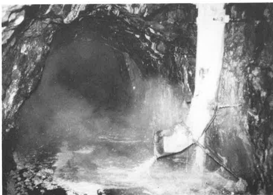
FIGUR 2 Avloppstunnel utförd med hård sprängning. Sewage tunnel excavated with hard blasting.
