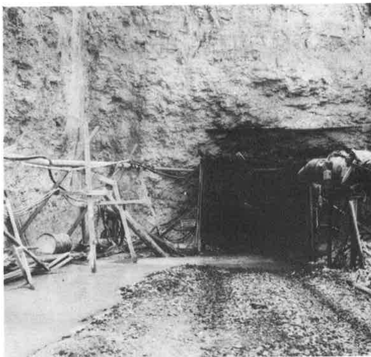
Bild 3. Tunnelpåslaget i kalkstensbrottet. Lägg märke till de vertikala väggarna som även i våra klimatförhållanden (frost) håller sig intakta.
