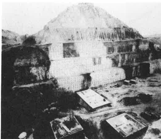
Fig. 8. Södra spillwayväggen efter avslutade sprängningsarbeten. Årsskiftet 1979/80.
