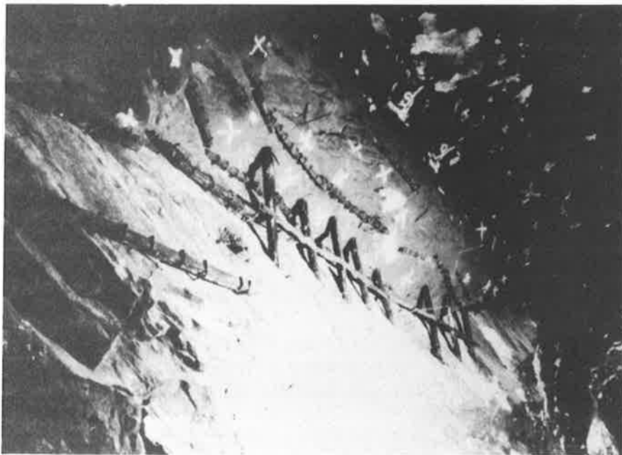
Fig. 6 Träförstärkningar i sektion l+490. Timber supports in section l+490.
