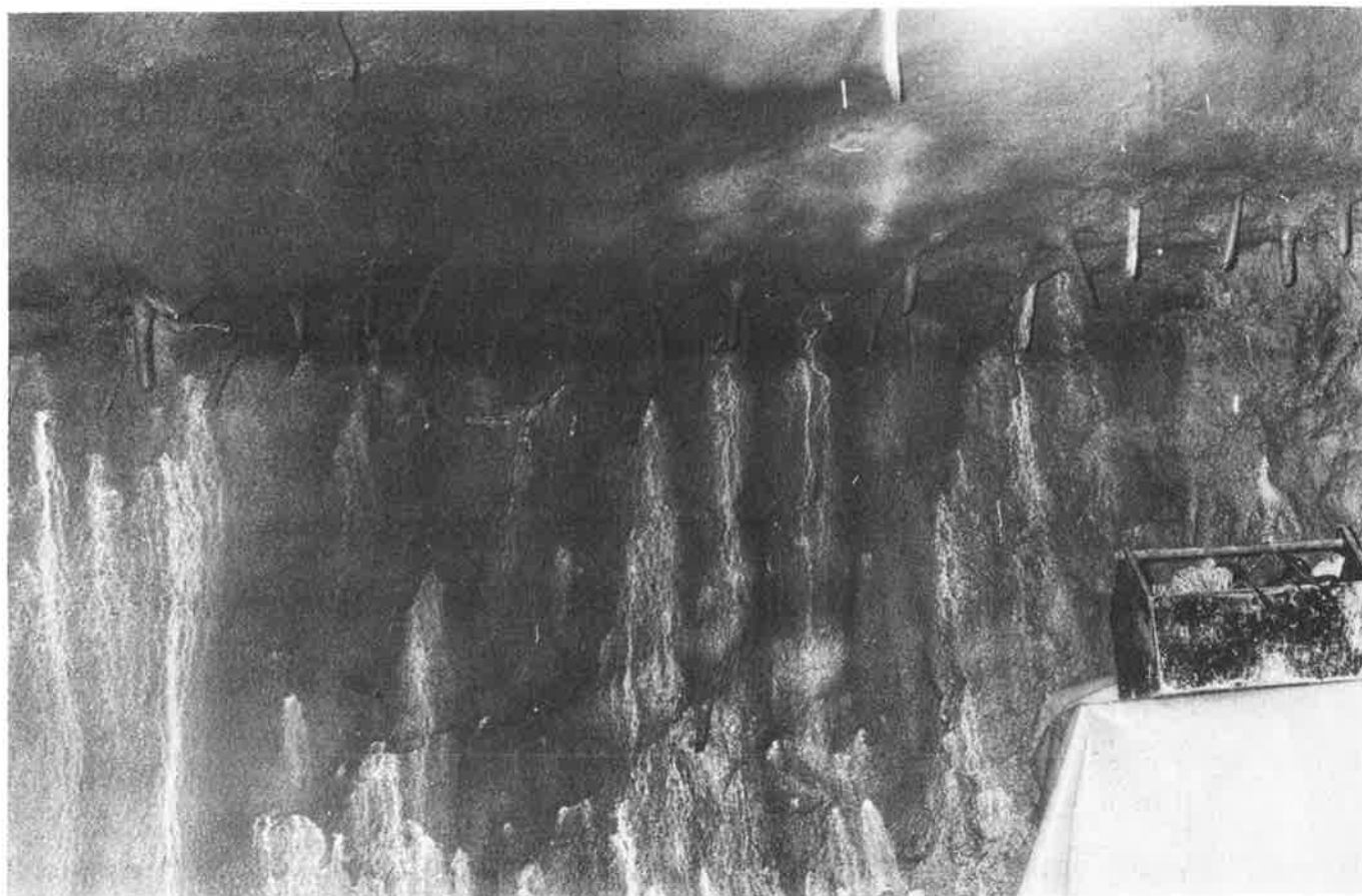
Bild 5. För applicering av sprutbetongen mot kalkberget i starkt läckande partier var det nödvändigt att genom dräneringsslangar förhindra att ett vattentryck byggdes upp.
