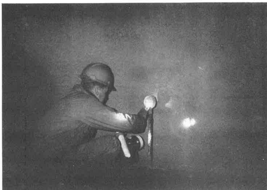
Bild 7. Även inifrån tunneln var det möjligt att följa grundvattentryckets variationer via tryckklockor. Detta gav möjlighet att följa effekten av tätningsarbetena.
