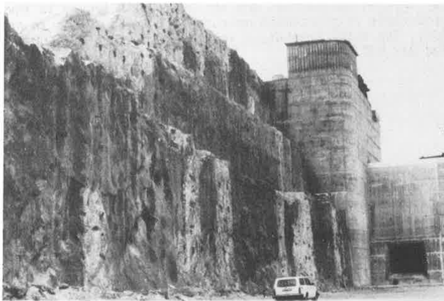
Fig. 9. Norra spillwayväggen 3 år efter avslutade sprängningsarbeten. North spillway wall 3 years after completed excavation.
