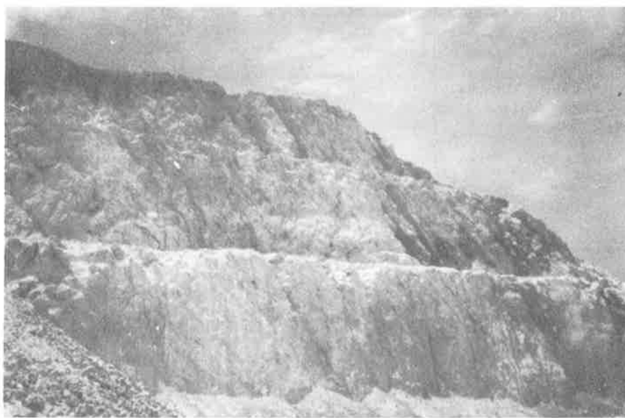
Fig. 4. Bergvägg i spillway vid de inledande sprängningsarbetena Front view of spillway walls at initial blasting phase
