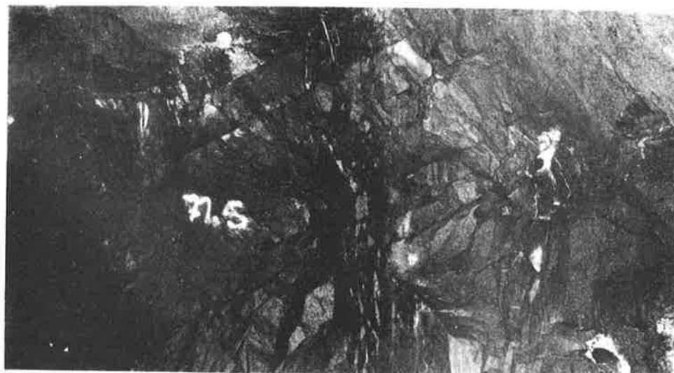
Fig. 5 Ortgaveln vid sektion 71,5. Sprickgrupp I var orienterad i N30^{\circ}W/30^{\circ}W . Norr är rakt in i kortet.
