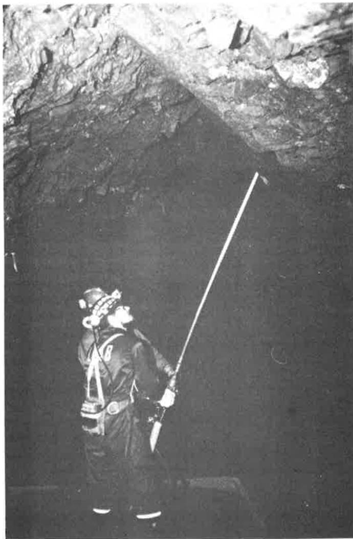
Fig 4 Montering av glasfiberbult med rotations- borrmaskin
