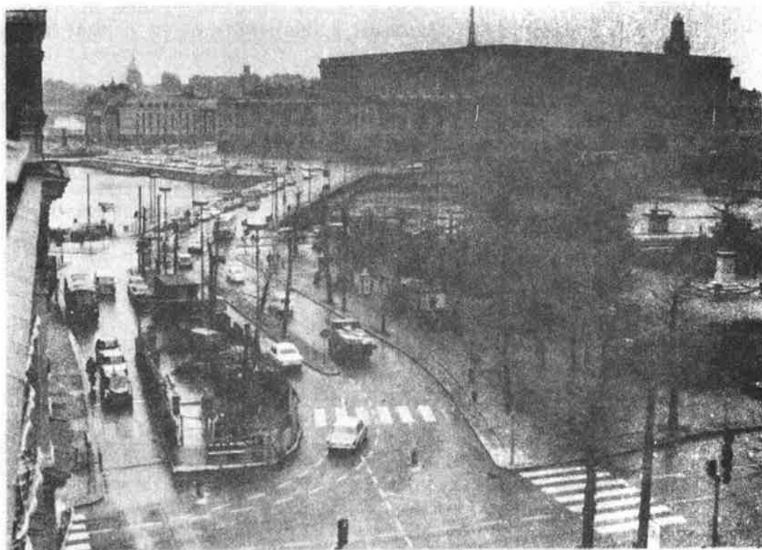
Översikt över arbetsplatsen för jordinjektering med slottet i bakgrunden.
