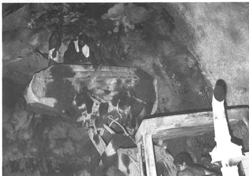
Mätning i utloppstunneln.
