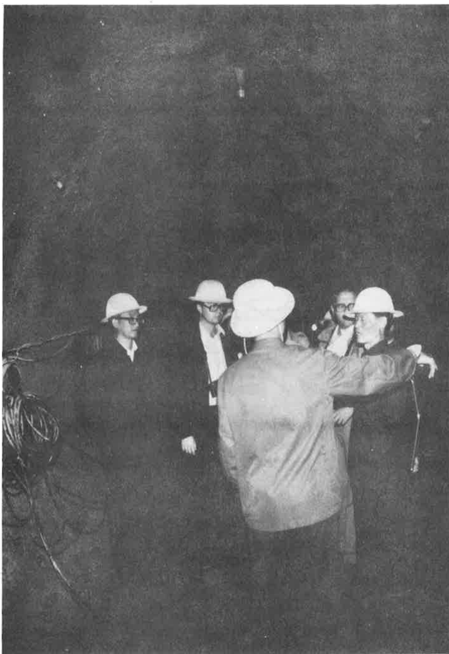
Figur 3.19 Bilden visar en av flera undersökningstunnlar som utförts för Lubuge kraftverksprojekt i södra Kina.
