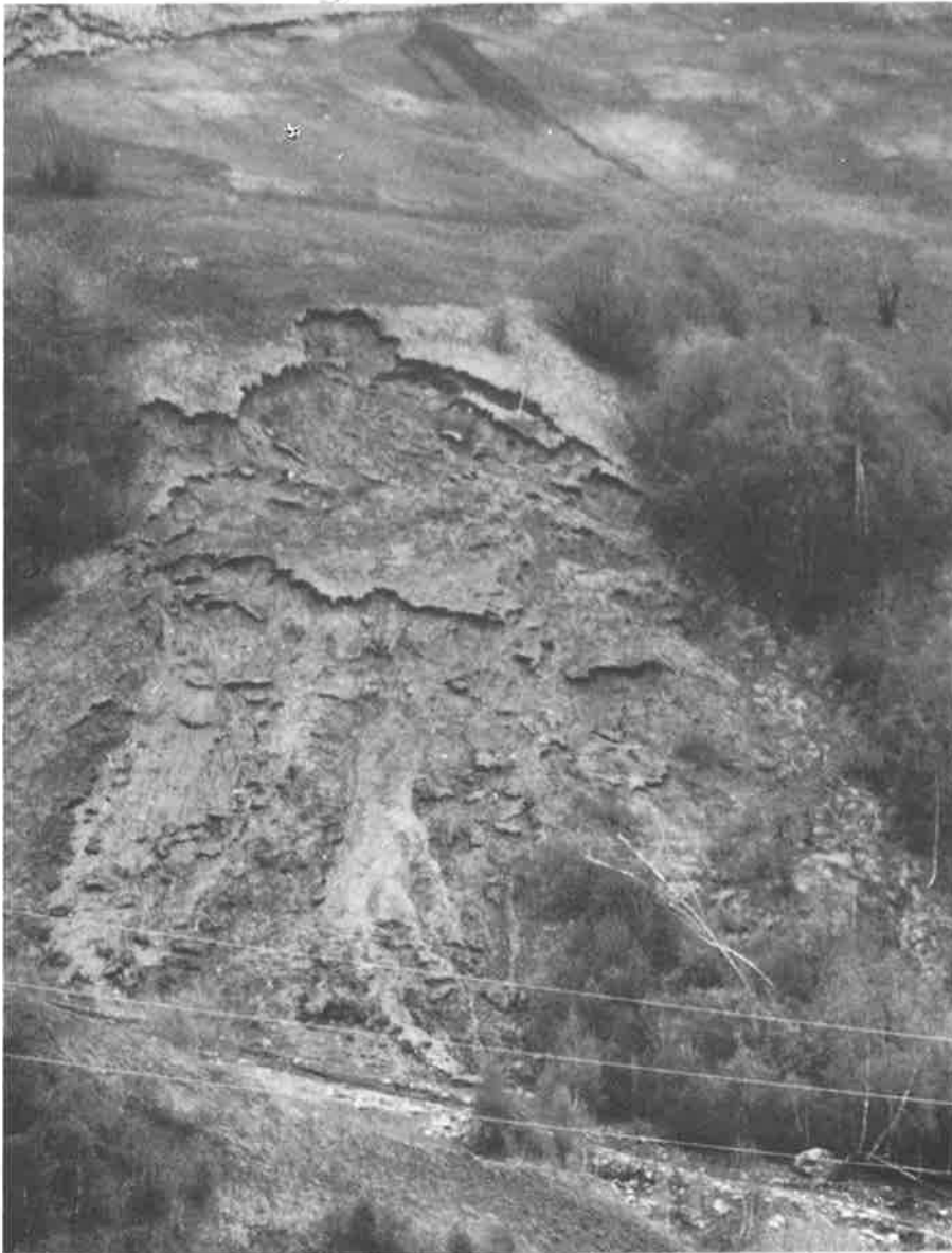
Figur 3.10 Skred som utlösts i samband med snösmältning. Sydvästra Frankrike.
