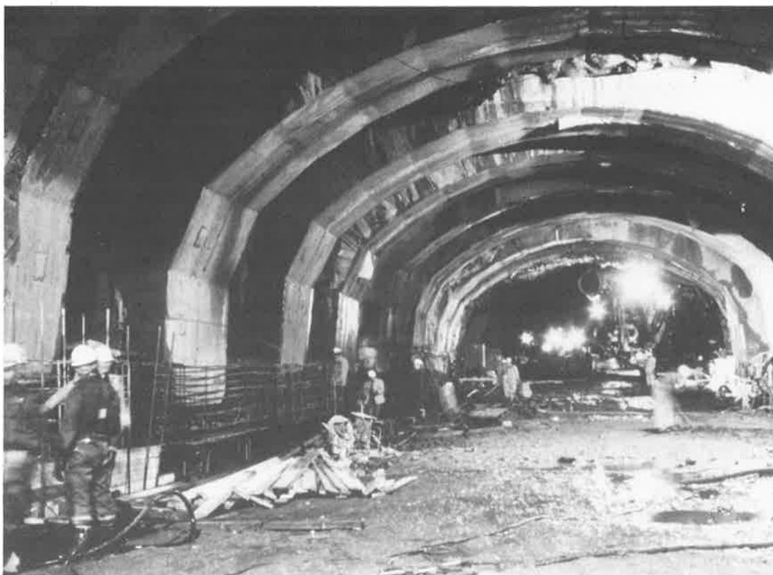
Figur 3.4 Platsgjutna förstärkningsbågar i Ligga avloppstunnel.
