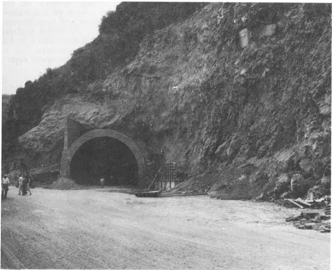
Figur 3.11 Vägtunnel på Teneriffa. Tunneln är i hela sin längd inklädd med prefabricerade betongbågar.
